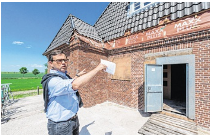
Erläutert den Rückbau des Gebäudes auf den ursprünglichen Zustand: Architekt Jörg Albrecht.
